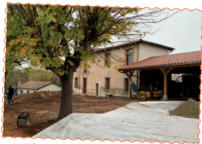
Rénovation de la cour de l'école
