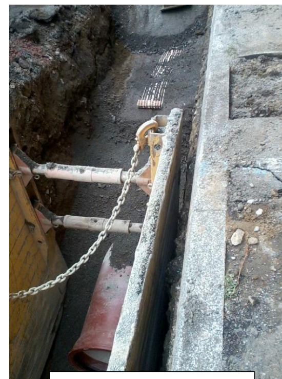
Travaux rue G Chapoton St Just St Rambert
