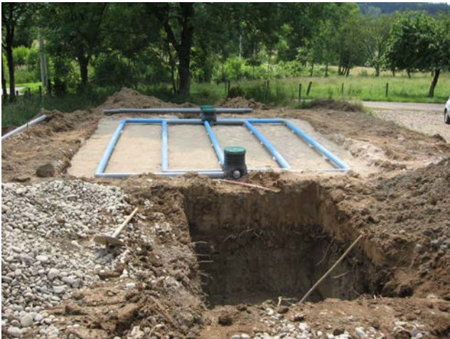
Photos illustrant la réalisation d'une installation d'assainissement non collectif par technique de filtre à sable.
